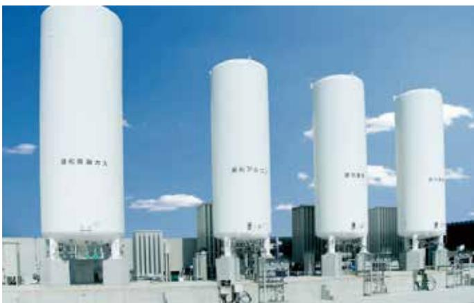
超低温液化ガス貯槽 CE (コールドエバポレーター)
